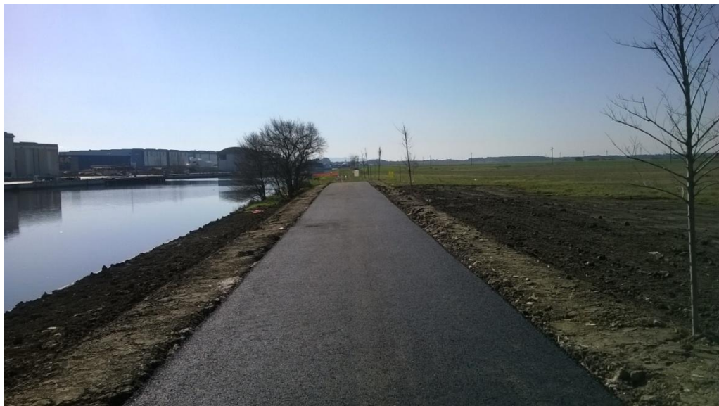
Figura 3: Tratto di strada costruito con l'utilizzo dei sedimenti nell'ambito del progetto Cleansed.
